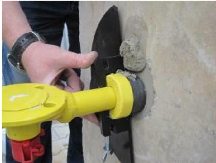
Die Geometrie der Schalungsplatte dient gleichzeitig als Schablone und garantiert die Einhaltung des korrekten Wandabstandes der HEK (Bild oben).
