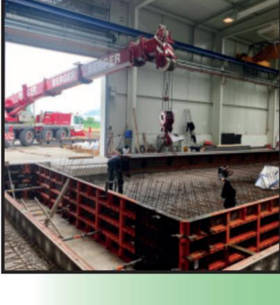
Vorbereiten der Fundamente und der Führungsschienen für den H<sub>2</sub> Prüfstand
