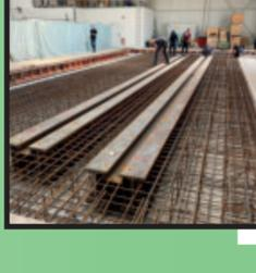
Ausrichten der Träger und Fertigstellung der Bewehrung vor dem Betonieren
