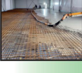
Einbringen des Betonbodens in der Lagerhalle, insgesamt ca. 85 m<sup>2</sup>
