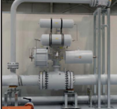
Ein Niwatec-Antrieb, Produkt der RMA-Gruppe (RMA Kehl GmbH & Co. KG), wurde auf einem Kugelhahn im Loop eingebaut.
